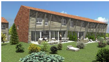
Villas mitoyennes à Massonnens "LINÉA" (8 villas + parking couvert)
