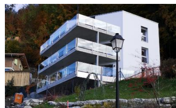
Immeuble d'habitation à Botterens (3 logements + parking)
