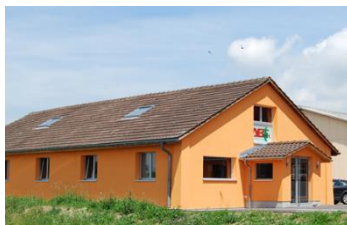
Bâtiment administratif CAR 96C – Ancien arsenal de Vaulruz « Dépôt à vélos »
