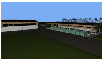
Déchèterie intercommunale STRID à Yverdon-Les-Bains
