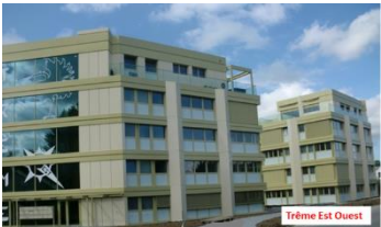
2 Immeubles PPE « Trème Est-Ouest » à Bulle (28 logements PPE + parking souterrain)
