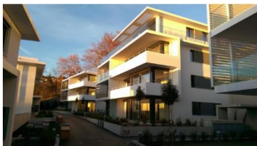
Immeuble d'habitation « Paudèze NORD » à Paudex (56 logements + parking souterrain)
