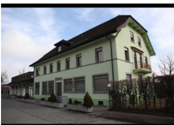
Transformation et aménagement du bâtiment AA – Ancien arsenal de Bulle
