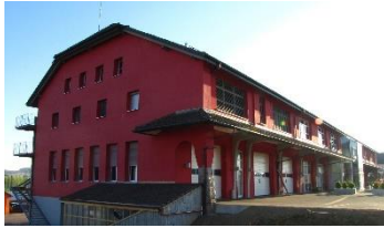
Bâtiment administratif-commercial-artisanal-médical Centre d'Activités Régional CAR 96A – Ancien arsenal de Vaulruz
